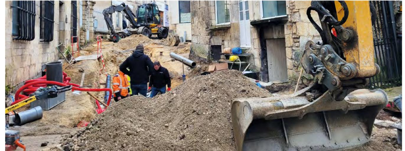
L'ensemble des réseaux est en cours de remplacement : les réseaux d'adduction d'eau potable, d'eaux usées et d'eaux pluviales. Tous les branchements des riverains sont repris et mis en conformité si nécessaire. Cette première étape a été réalisée par les entreprises Colas et Renevier. La remise à neuf de ces réseaux vétustes et fuyards est gage d'économie de la ressource en eau.
